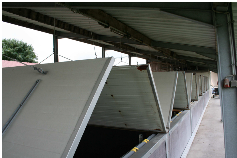
Slika 12: Pokrita ležišča v hlevih z zunanjo klimo s kontrolnega hodnika
