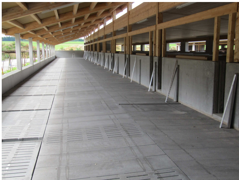
Slika 10: Polne betonske plošče, pomešane z rešetkami za ureditev ležalnega dela kotcev za pitanje
