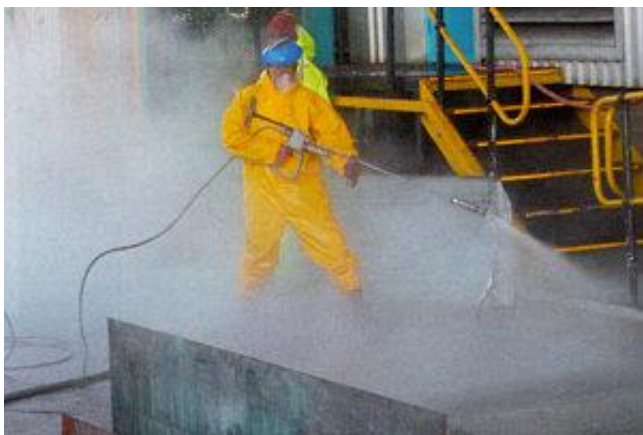
Slika 18: Razkuževanje z visokotlačno črpalko (Vir: http://www.drizit.co.za/high-pressure-cleaning.php ).
