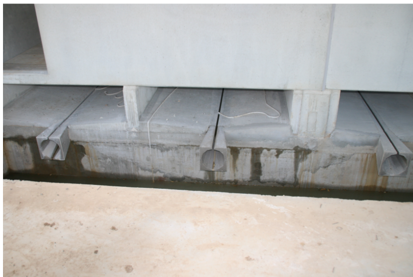
Slika 5: Ureditev kanalov za ločevanje tekočin in blata
