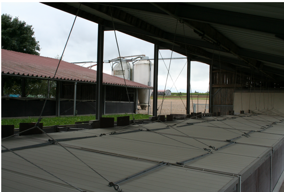
Slika 2: Zunanja zaščitna ograja ob silosih okrog nizkoenergijskih hlevov z zunanjo klimo za prašiče pitance
