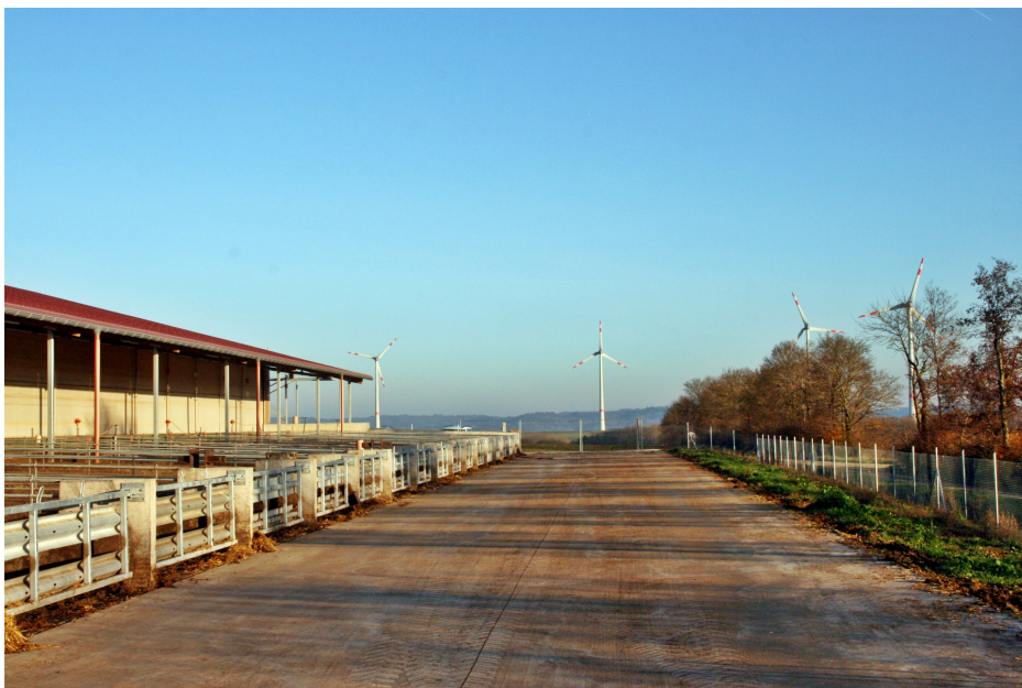
Slika 1: Dvojna zaščitna ograja, ločena z asfaltirano potjo
