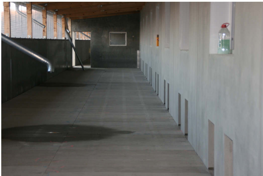
Slika 13: Vgradnja mrež na izpustih za preprečevanje vstopa pticam in insektom
