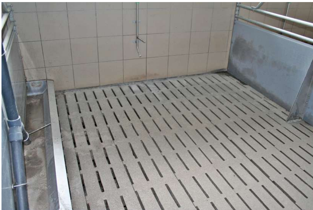
Slika 22: Pravilno očiščen kotec, pripravljen za novo uhlevljanje pitancev
