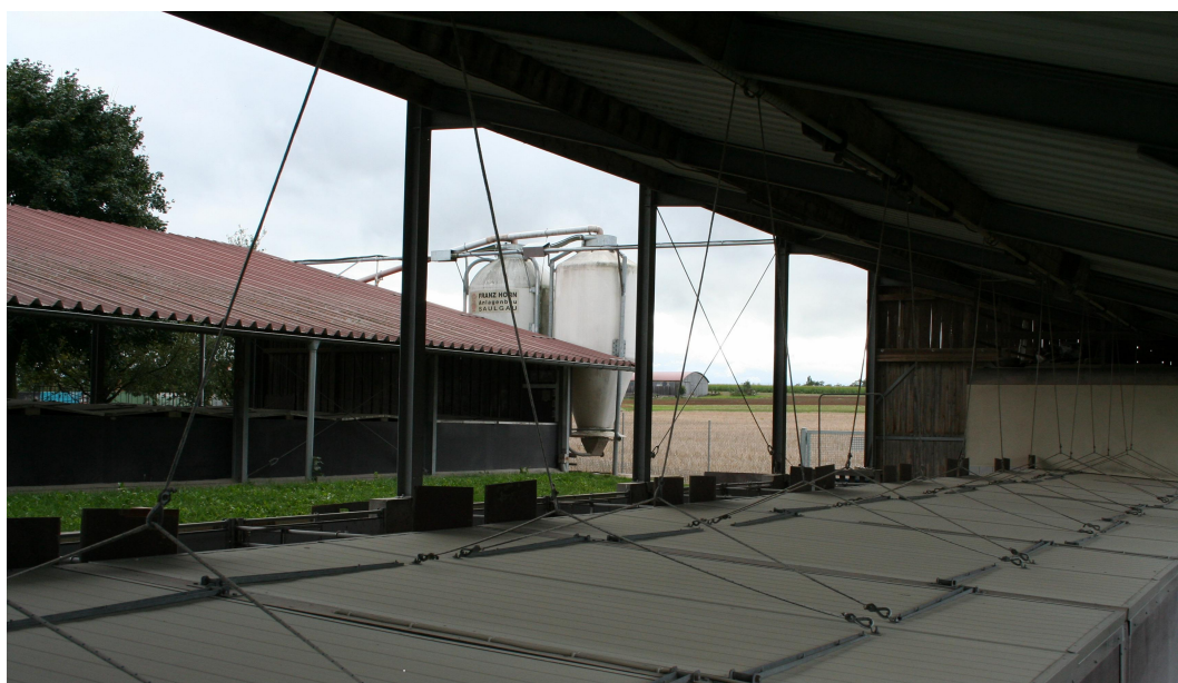
Slika 18: Zunanja zaščitna ograja ob silosih okrog nizkoenergijskih hlevov z zunanjo klimo za prašiče pitance
