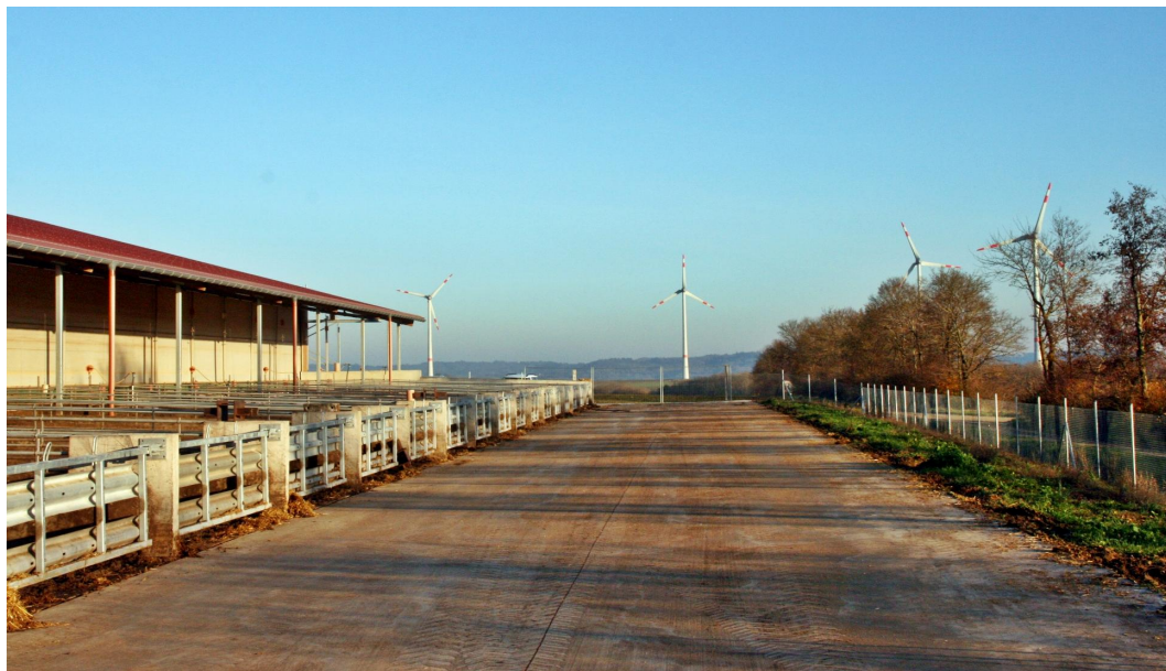
Slika 17: Dvojna zaščitna ograja okrog hleva z zunanjo klimo, ograji ločeni z asfaltirano potjo za notranji transport
