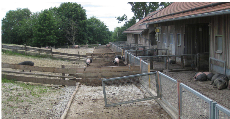
Slika 3: Izpusti za svinje na kmetiji z nadstandardno uhlevitvijo v Nemčiji
