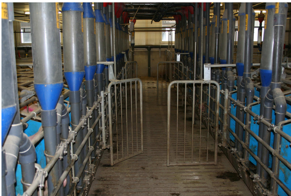
Slika 5: Pregrade za omejevanje merjasca pred odstavljenimi svinjami
