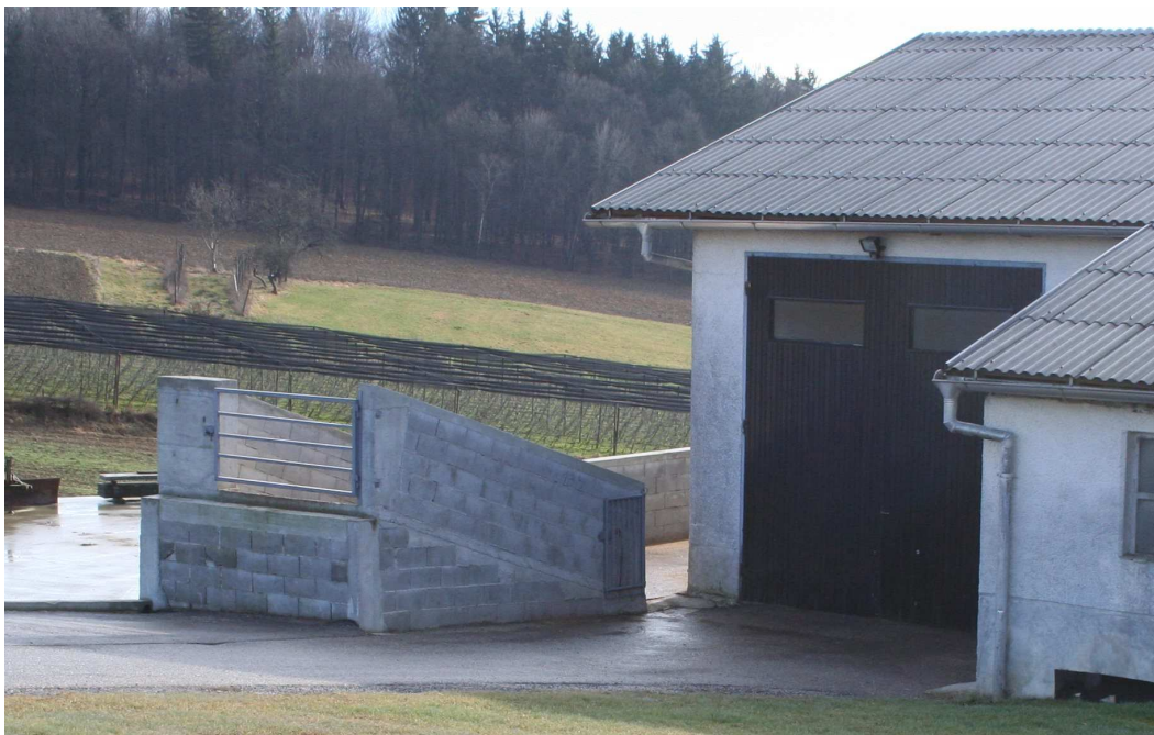
Slika 12: Urejena nakladalna rampa za prašiče na kmetiji
