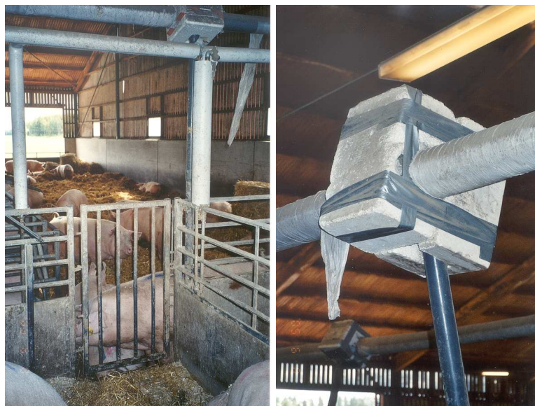
Slika 6: Čakališče v odprtem hlevu (levo), zaščita cevi pred zmrzaljo (desno)
