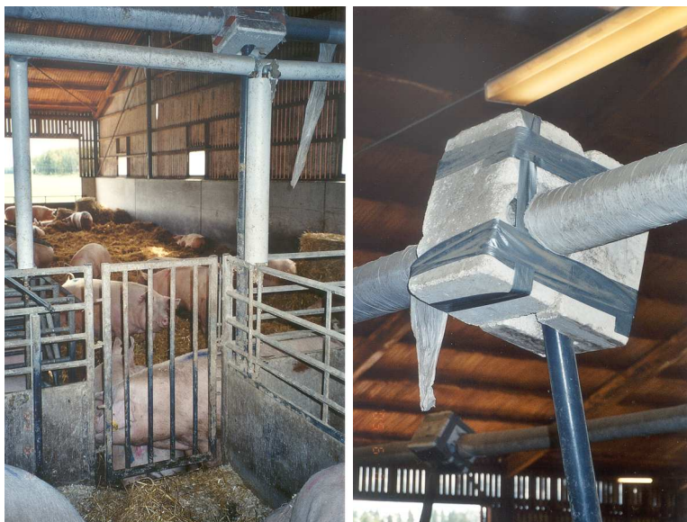
Slika 6: Čakališče v odprtem hlevu (levo), zaščita cevi pred zmrzaljo (desno)
